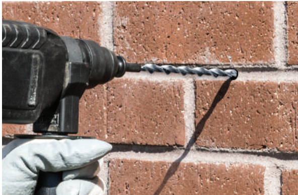
Heli-Tie Helical Wall Tie
