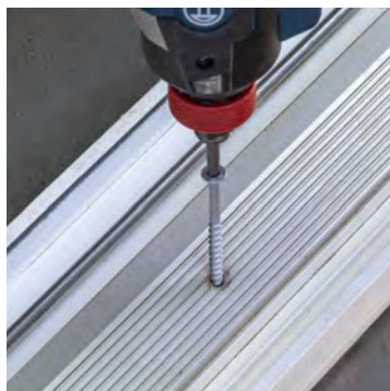
Instalación de riel de puerta corrediza
