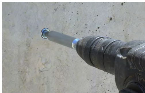
Inserción del anclaje con la herramienta de inserción SDS.
