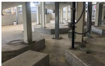
Entorno medianamente corrosivo típico: anclaje exterior
