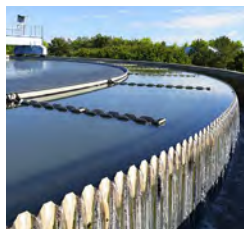
Entorno severamente corrosivo típico: plantas de tratamiento de aguas residuales
