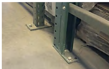
Entorno con un nivel bajo de corrosión típico: depósito interior
